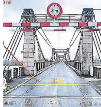
Les travaux de sécurisation auront lieu le 30 juin.
