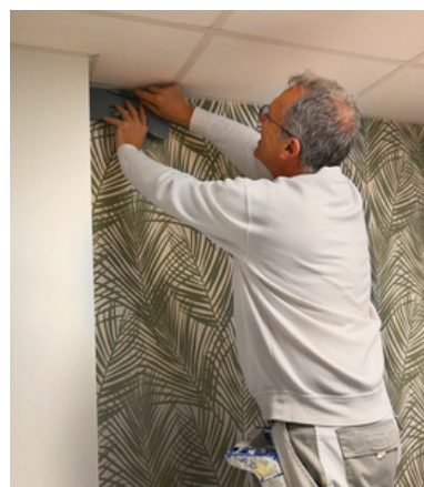
Travaux de second œuvre
