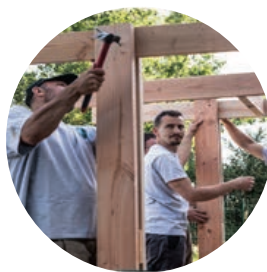
Installation d'une pergola
