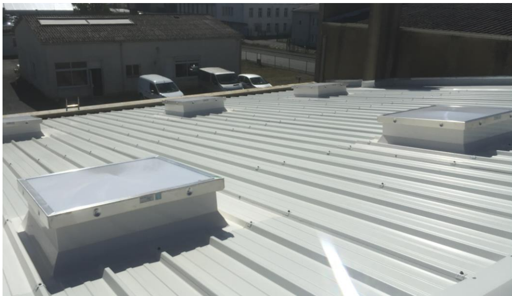
Septembre 2020 : Nouvelle toiture et pause des puits de lumière
